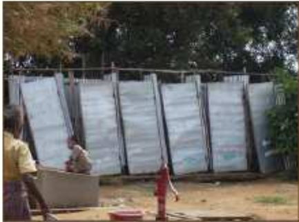
Toilet di tempat penampungan sementara
